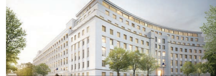
MINISTÈRE ILOT SÉCURITÉ FONTENAY - PARIS / BÂTIMENT ADMINISTRATIF / 46.000M 2 / BRAUN + ASSOCIÉS ARCHITECTES
